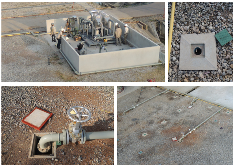
ภาพที่ 9: การติดตั้งระบบสกัดไอน้ำดินในพื้นที่สาธิตการฟื้นฟู
